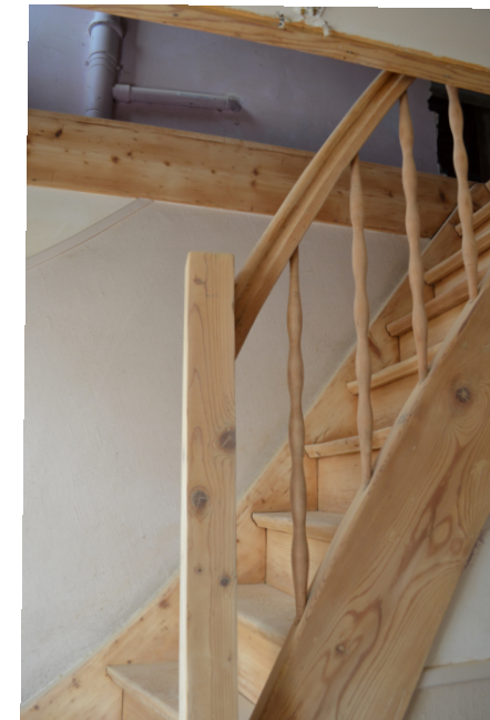
Eine erste Treppe ist geschliffen
